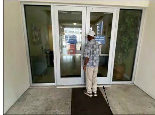
2 PHOTO @ ENTRY DOOR A-143 N.T.S.
